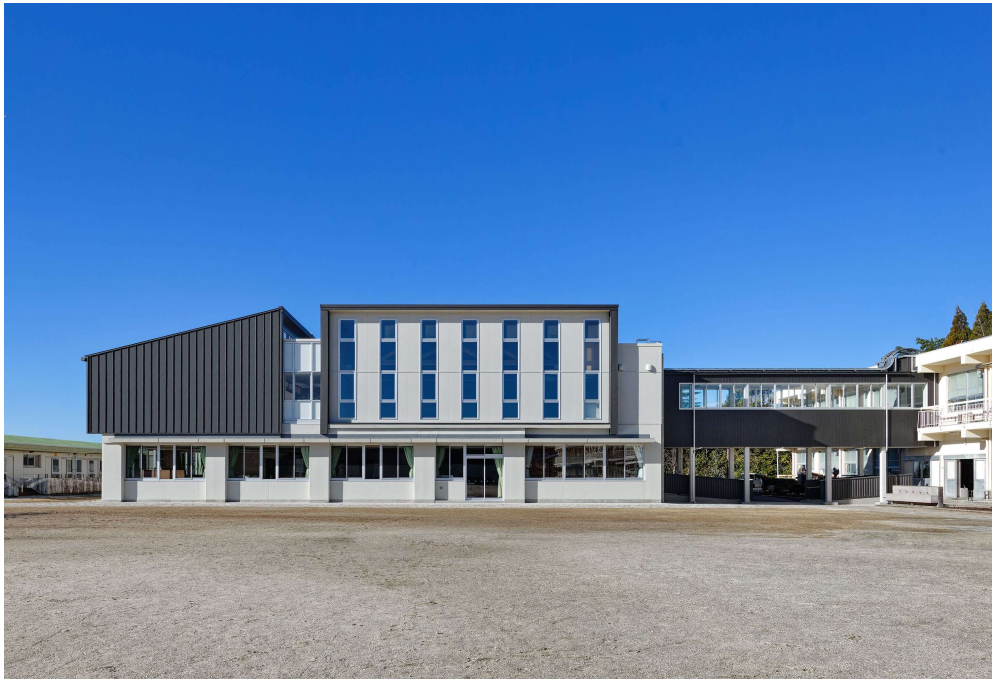
豊田市中山小学校 増築校舎
