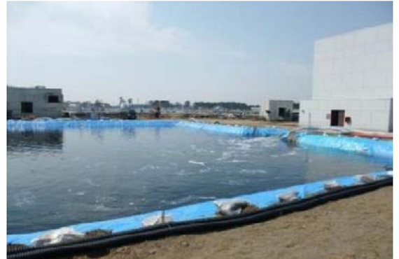
仮設沈殿池を用いた簡易処理の例
