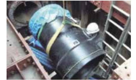
(水道管の耐震化工事)
