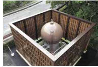
（飲料用循環式耐震性貯水水槽）
