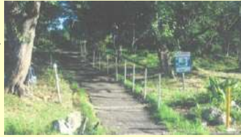
手すりが完成しました
