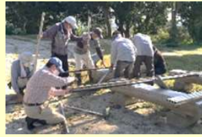
手すり組立の様子
