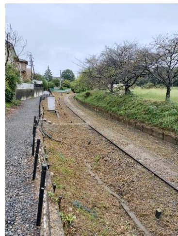
👉 保全作業後の廃線敷
