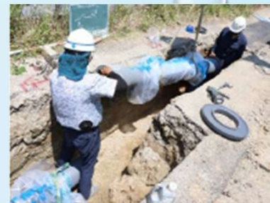
<管路の耐震化工事>
