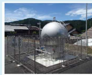
<飲料用循環式耐震性貯水槽>
