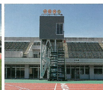
写真判定装置塔
