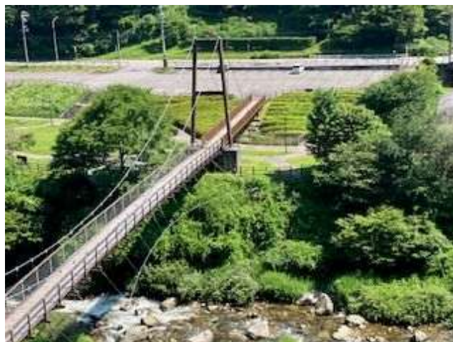
橋全体の様子
