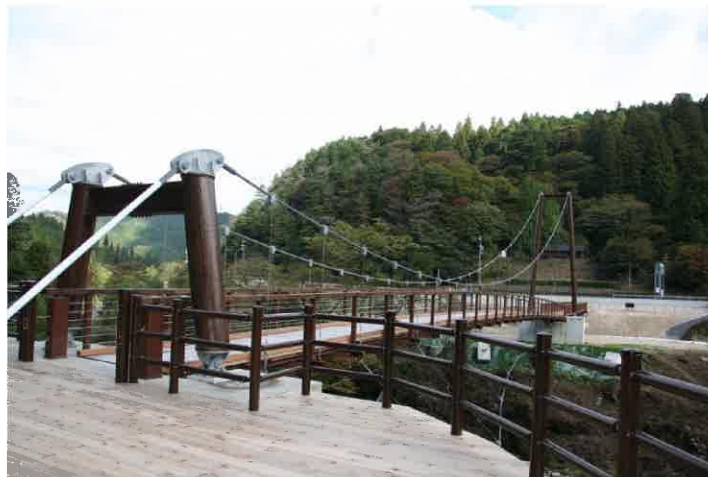
橋全体の様子
