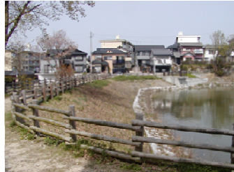
雨水流出抑制施設としての整備例(丸藪池)
