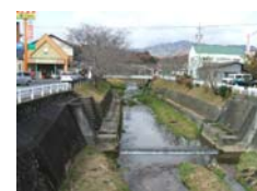
②飯野川 藤岡支所付近
