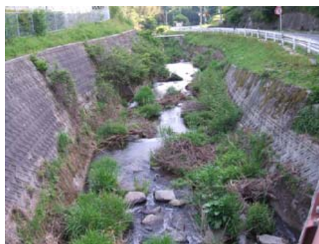
図 24 コンクリート整備された河川護岸(田代川、小原支所付近)
