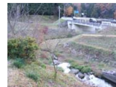
⑥太田川 多自然護岸区間
