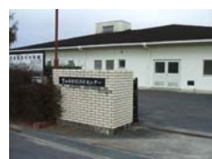
①農業集落排水処理場 (伊保浄化センター)
