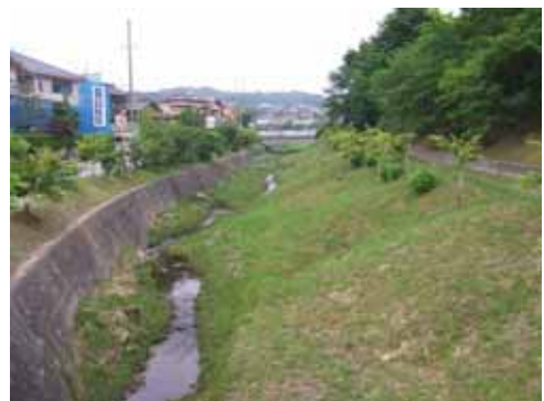
加茂川の多自然護岸区間
