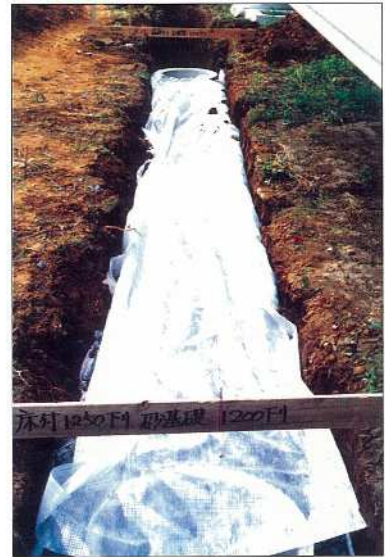
図 8-6 透水シート覆工後の状況
