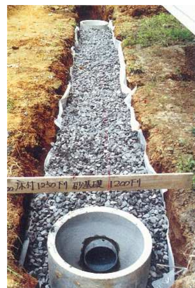
図 8-4 ます、透水管の据付
