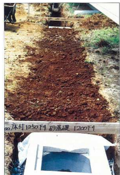
図 8-7 埋戻し状況
