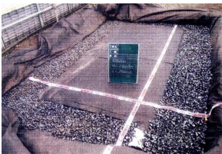
図 8-13 地下埋設部の出来形写真の例
