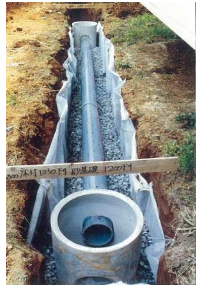
図 8-5 充填砕石工の完了
