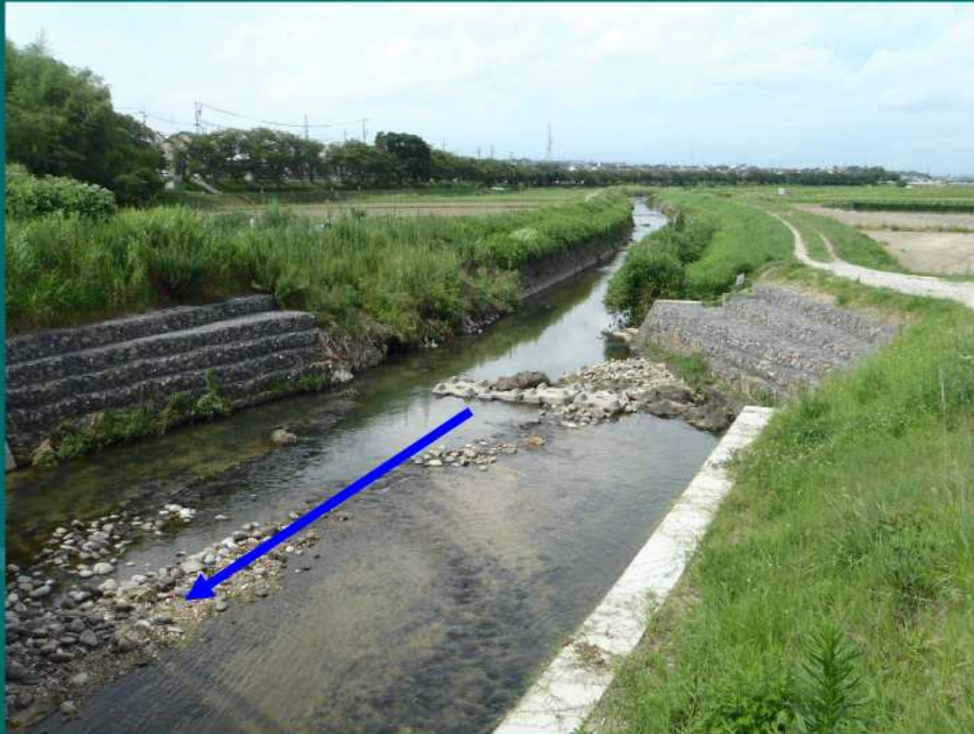
逢妻男川の改修状況(豊田市高美町地内)
