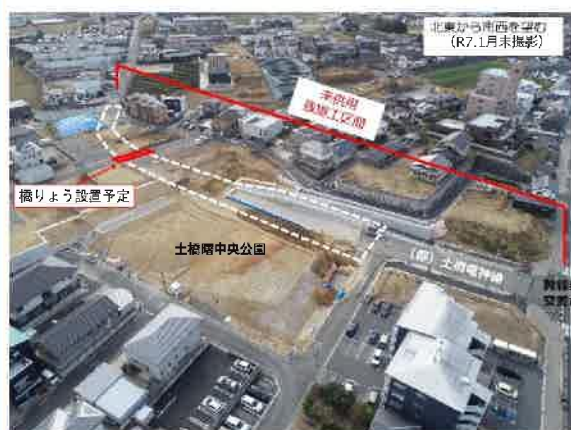
(都) 土橋竜神線残工事区間全景 写真提供：太啓建設（株）
