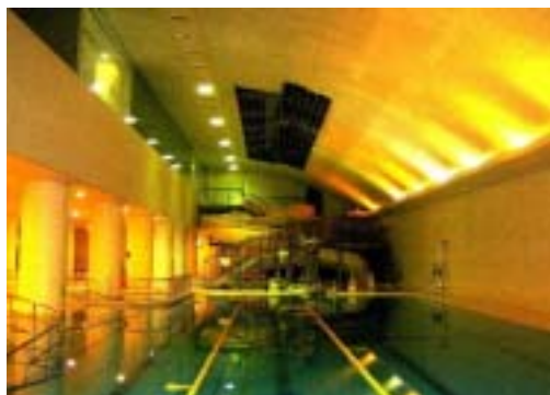
落下事故全景、上部の黒い所が落下した天井部分
