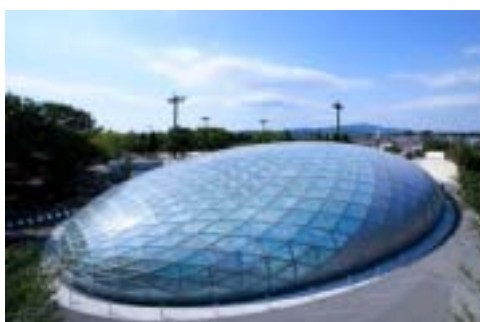
平成19年に完成した水泳場(屋内プール)の外観
