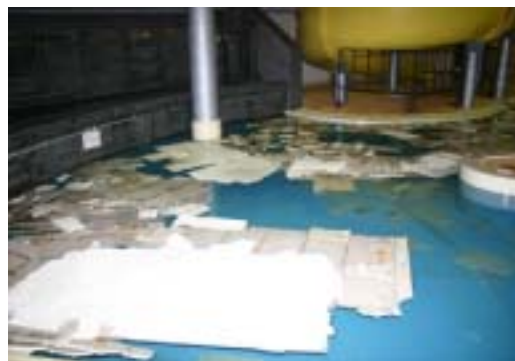
プールに浮くけい酸カルシウム板
