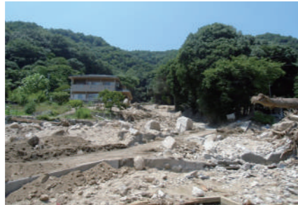
崩壊した斜面
