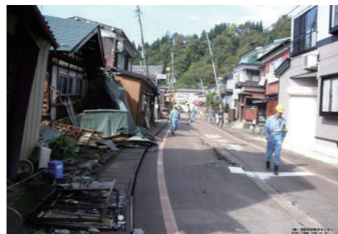
住家被害、大きく傾く電柱、道路のアスファルトの陥没
