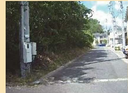
平成12年東海豪雨 被害箇所②
