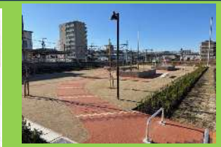
写真3 土橋駅北公園 工事進捗状況(12月現在)
