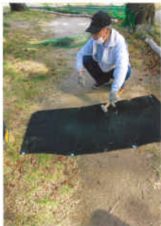
桜の木の根っ子をマットで覆いかぶせる安全整備
