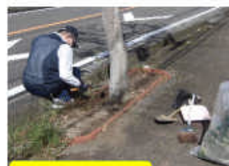
根切り作業 (令和6年10月21日)
