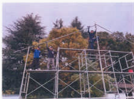
足場組立作業
