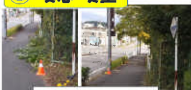
五ヶ丘浄化センター西
