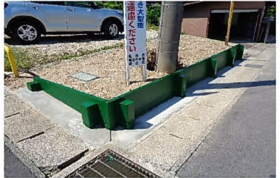
土留め工事後
