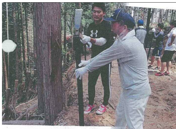
展望台通路案内杭打ち作業の様子
