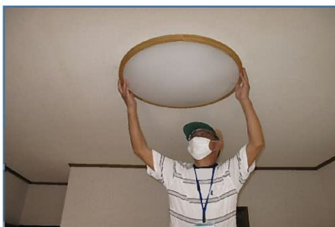
照明器具取替の様子（2年9月）
