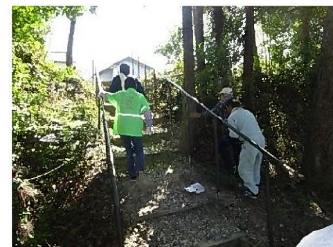
西中山ふれあい広場 遊歩道手摺整備 (2年10月)
