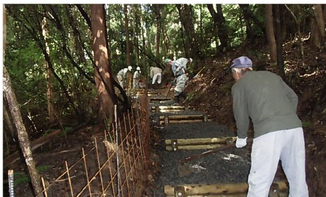
階段取付けの様子（2年5月）
