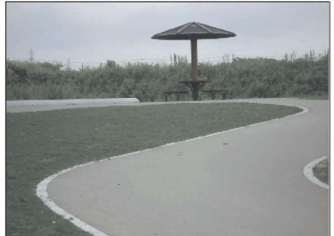
周遊散策道の途中に休憩所を設け、東屋とベンチを設置して、休憩場所と憩の場として利用していただけるように整備を行なった。(平成22年度)
