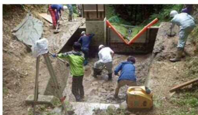
〈土砂流出量計測のための砂出し作業〉
