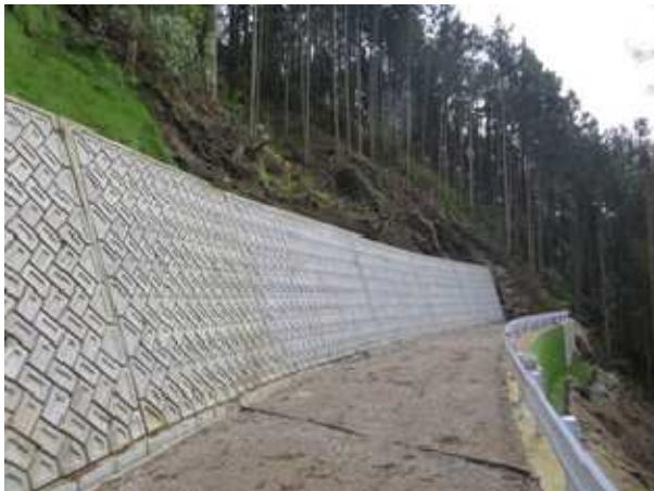
<林道開設（大日影支線・足助地区）>
