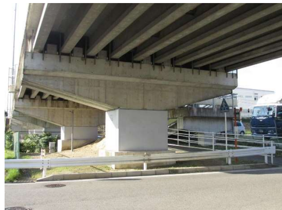
耐震対策事例（鋼板巻き立て）
