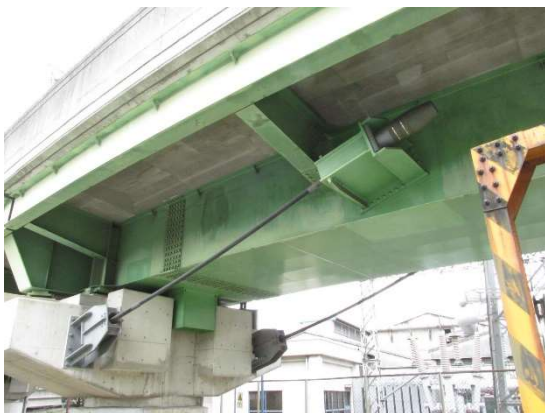
耐震対策事例（落橋防止装置）
