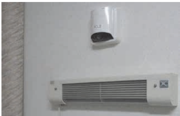
施設での機器設置状況
