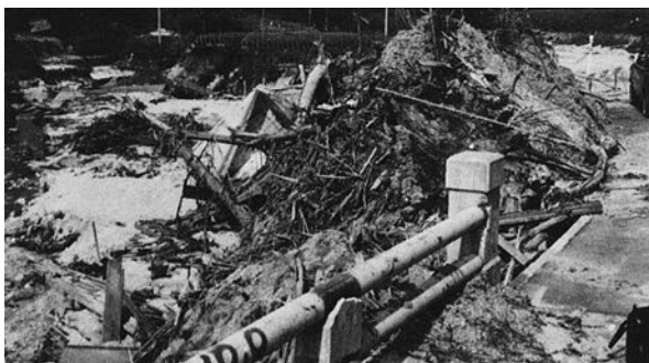
全壊流失した東市野々公民館
