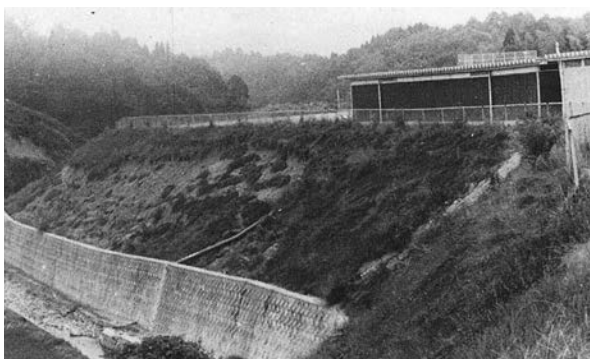
はみだした村民運動広場の擁壁
