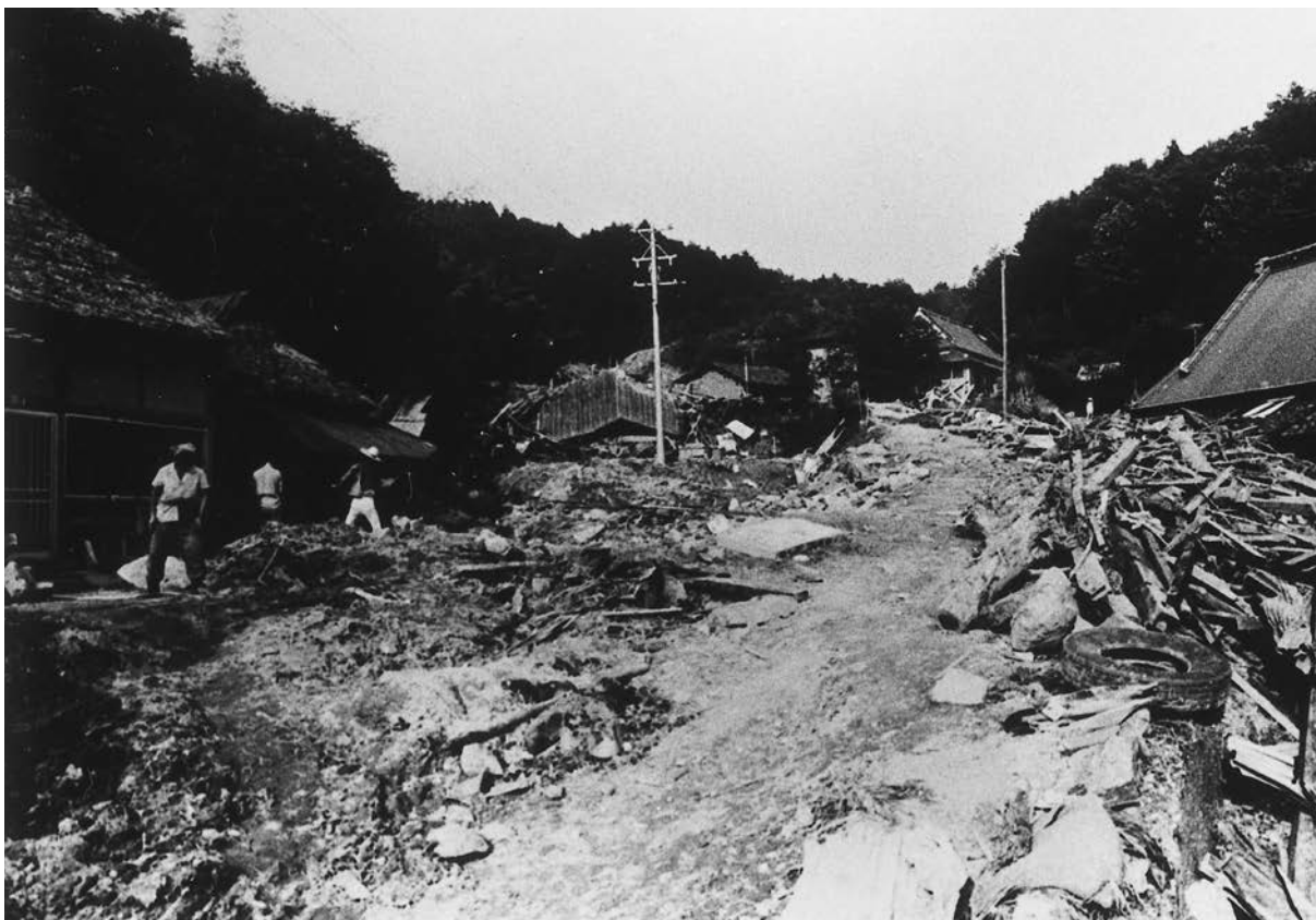
流出した土石と家屋廃材（下仁木）
