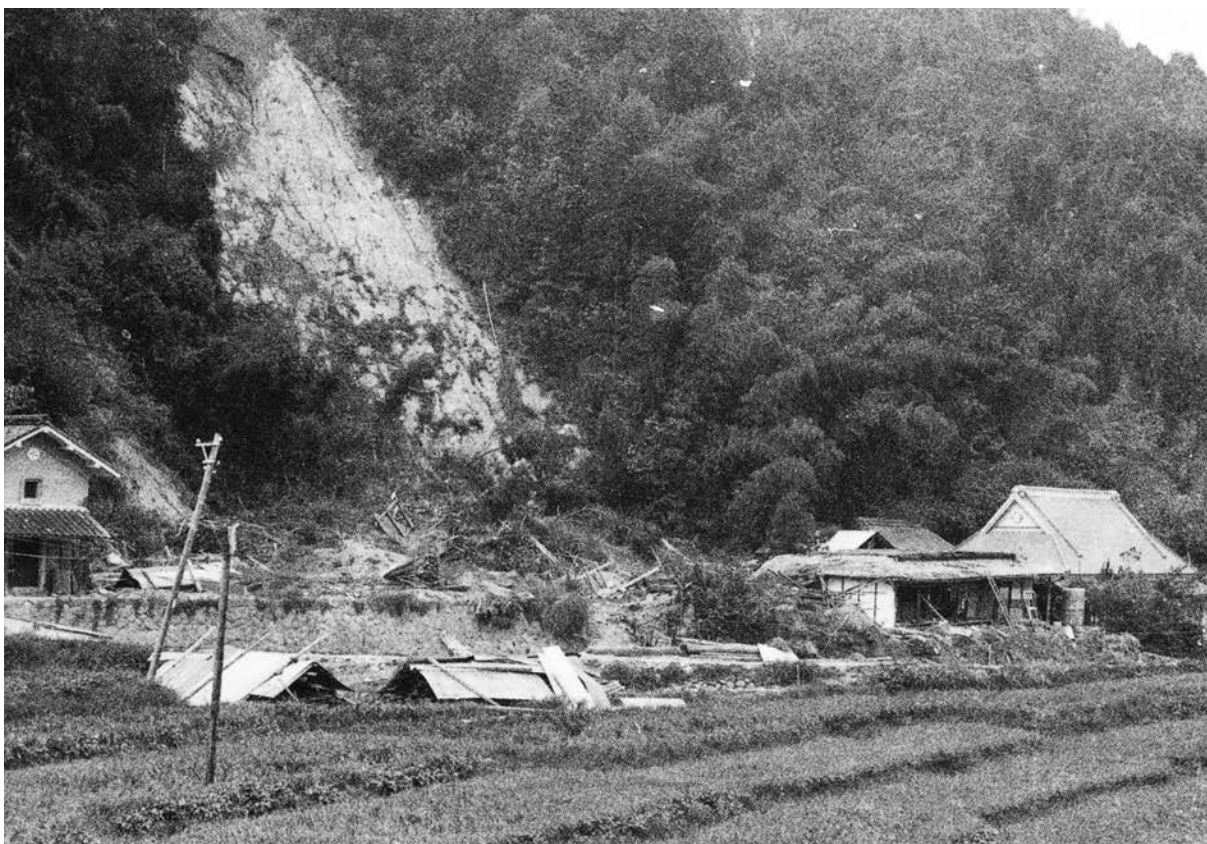
土砂崩れによる家屋全壊（平畑）
