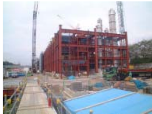
工事現場（南側から）
