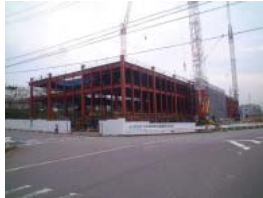
工事現場（北側から）
