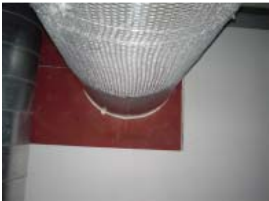
蒸留エリアの天井裏（一般管理区域）
