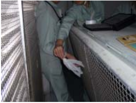
11月29日(火) 第6系統排気ダクト内のPCB除去作業
