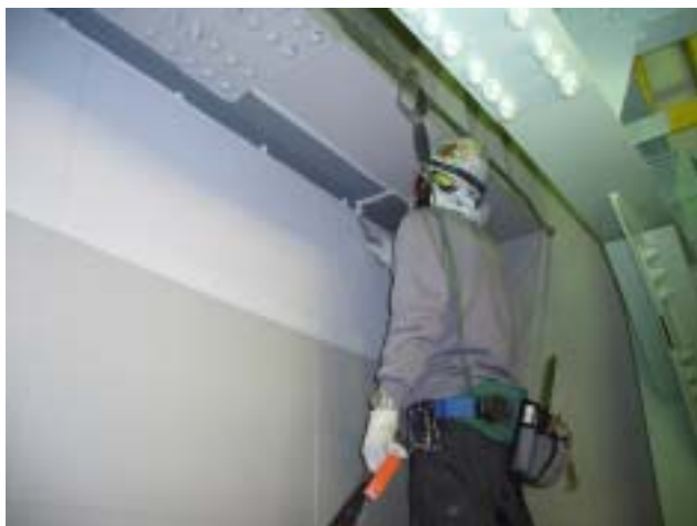
隙間処理作業
