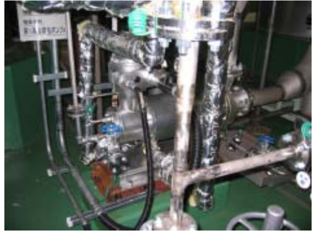
事故対策確認（塔底ポンプの改造）
