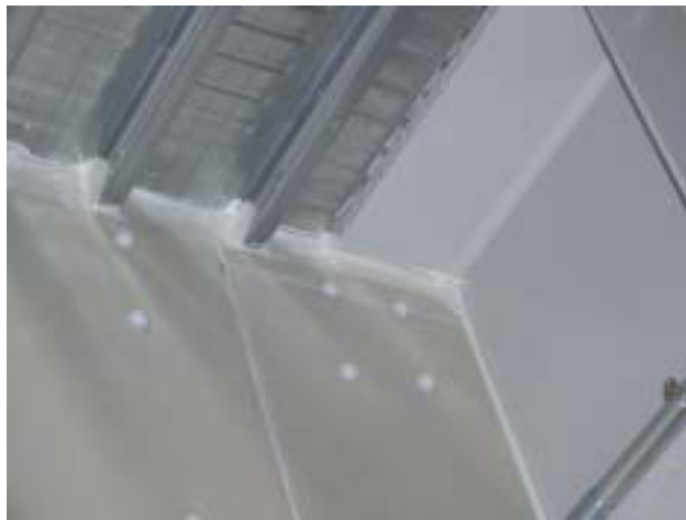
隙間処理作業実施後
