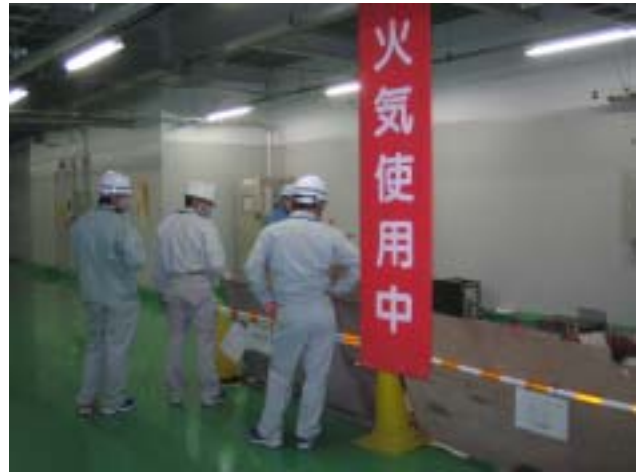
対策工事用作業現場の確認
