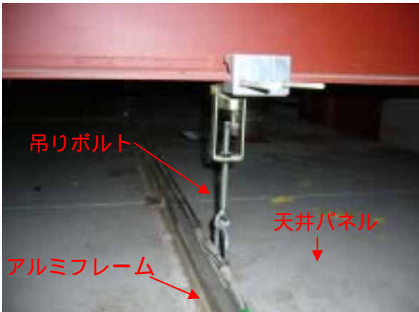
NO. 3 遮蔽フード天井吊り材状況
