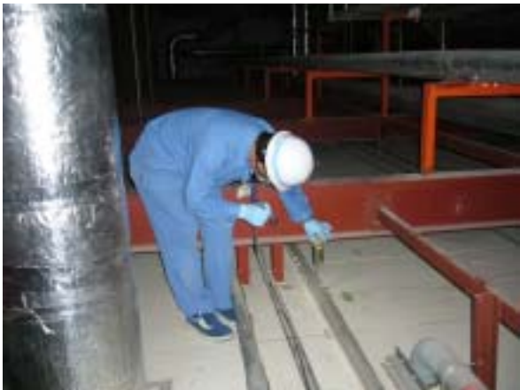
NO. 5 遮蔽フード天井裏点検状況(4)
