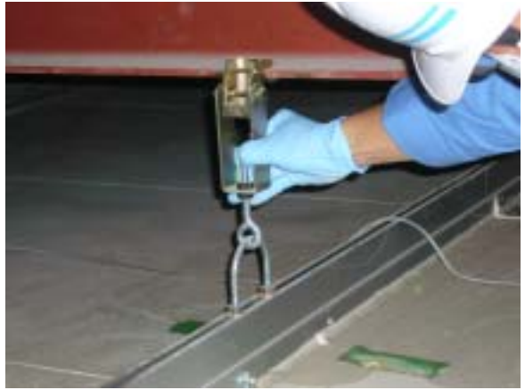
NO. 2 遮蔽フード壁裏点検状況(2)
