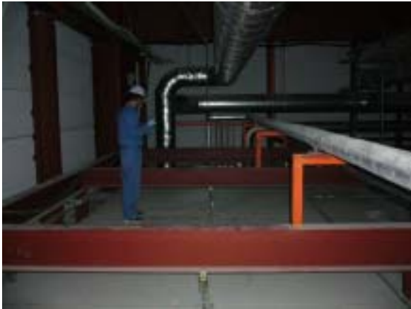
NO. 1 遮蔽フード天井裏点検状況(1)
