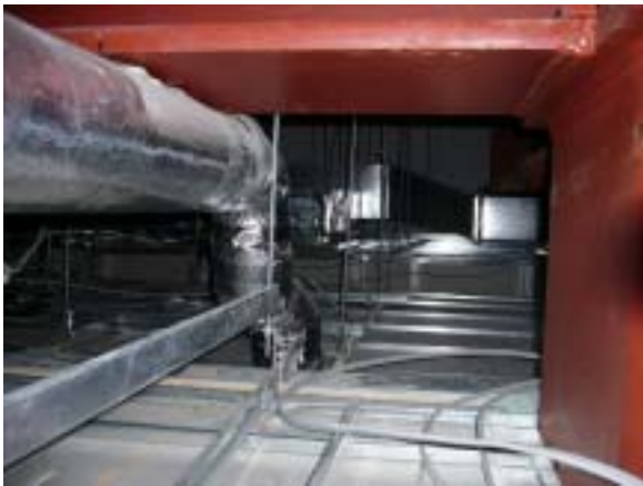
NO. 9 吊り天井裏状況(3)
