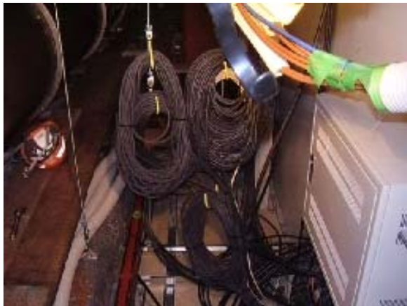
NO. 12 整線後の状態
