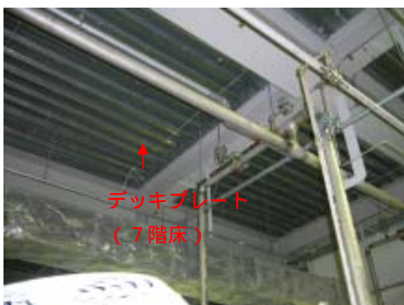
NO.13 PCB分解エリア天井状況
