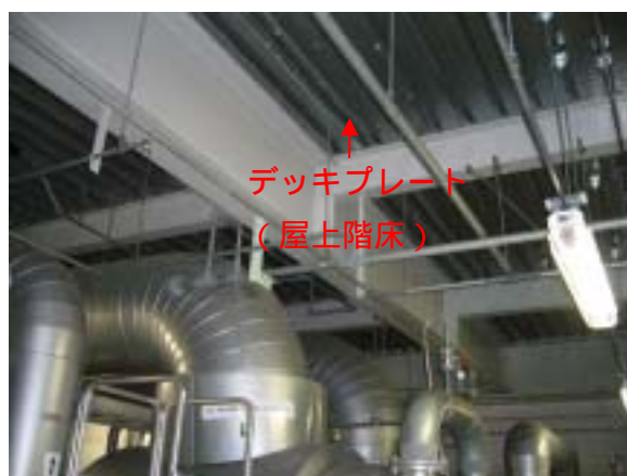
NO.14 蒸留エリア天井状況
