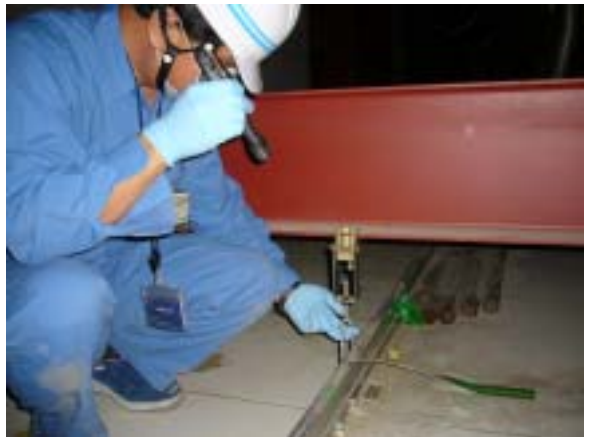
NO. 4 遮蔽フード天井裏点検状況(3)
