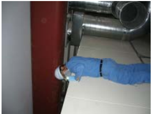
NO. 6 遮蔽フード天井裏点検状況(5)
