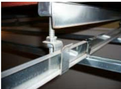
写真 4 クリップの施工写真(1)
