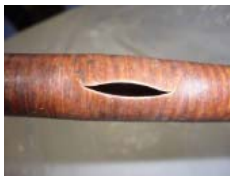
破裂した銅チューブ
