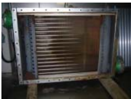
取り外した熱交換器
