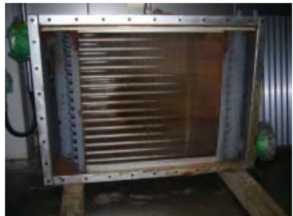
取り外した熱交換器
