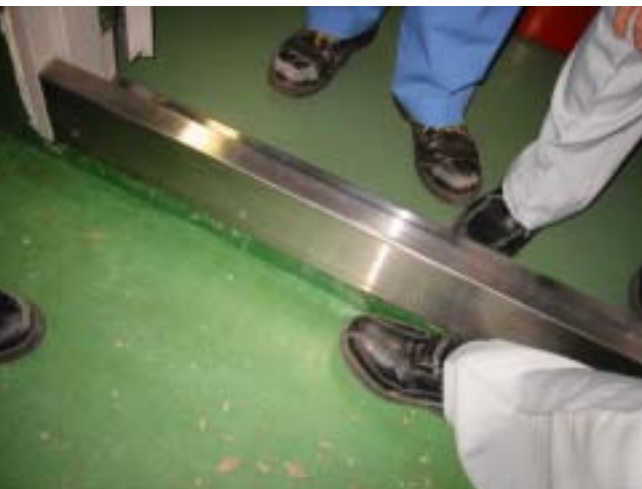
1- : 工程分離液処理室防液堤
