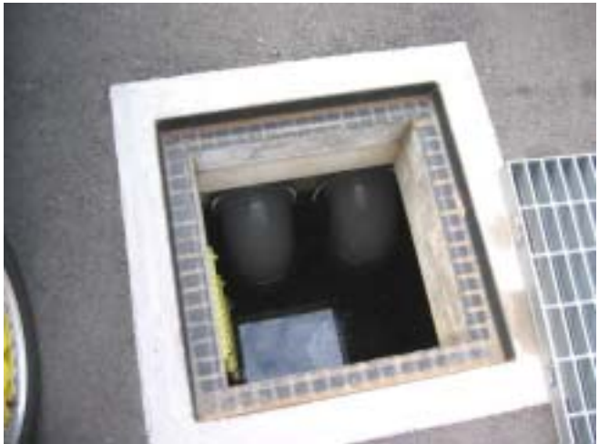
1- : 油水分離槽（配管設置対応後）
