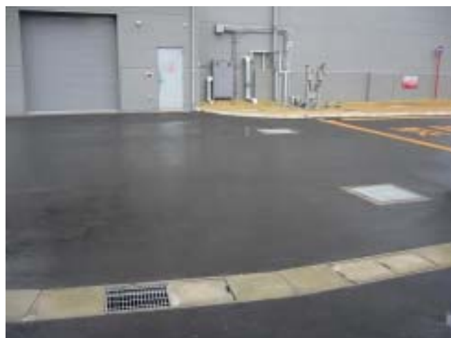
1- : 屋外漏洩現場 (事故後)
