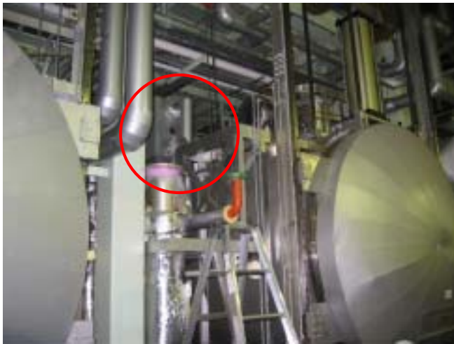
-1 熱交換器設置箇所（降ろした後）
