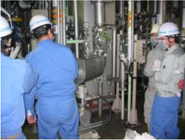
真空加熱分離炉のドレンタンク確認
