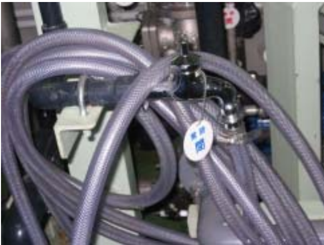
蛇口の一部を取外したこと、「常時閉」の表示による漏洩対策
