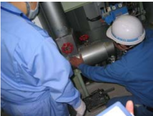
第 2 蒸留塔起動作業
