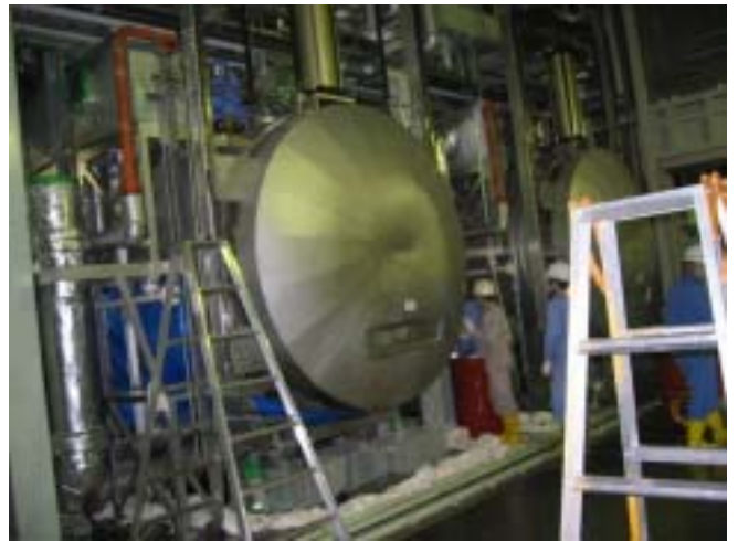
真空加熱炉洗浄作業
