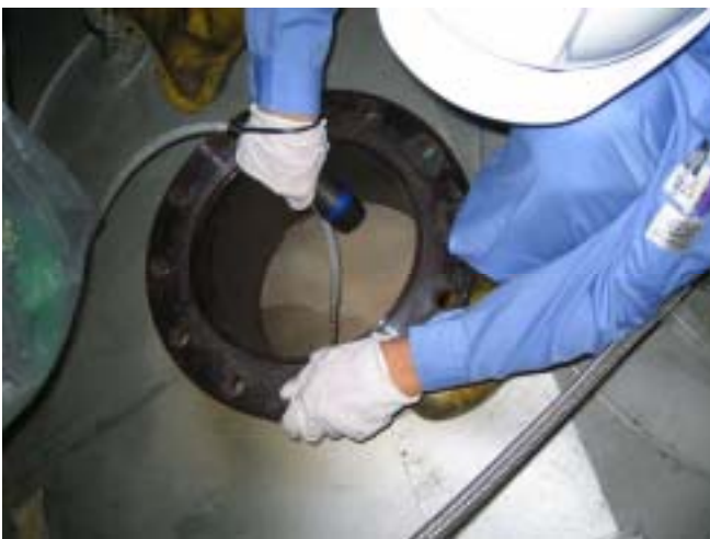
真空加熱炉洗浄作業（上部から水による）
