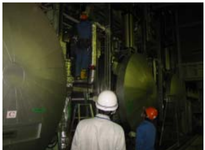
熱交換器配管の気密試験立会
