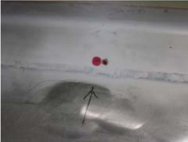
溶接の点検作業（傷があると着色）
