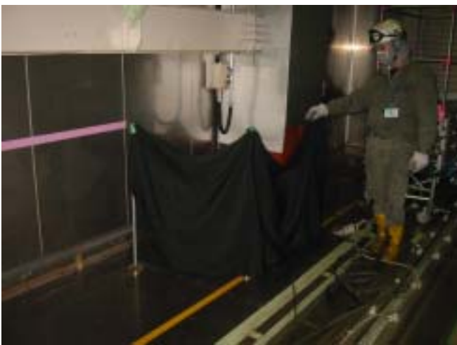
溶接状況の確認
