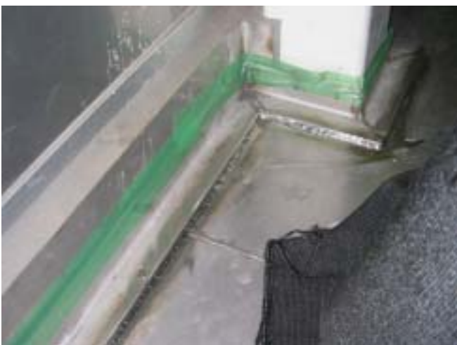
溶接状況の確認
