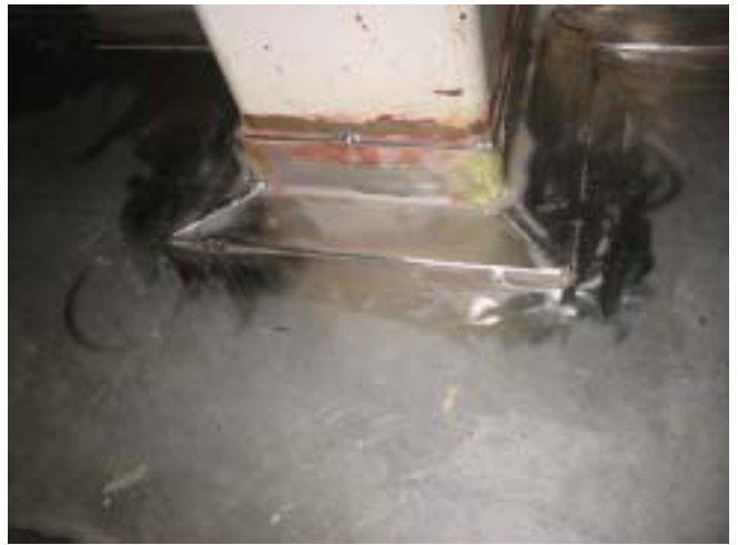
コーキングの除去状況の確認
