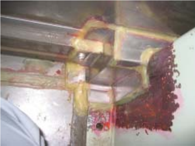
コーキング困難箇所の対応（囲い込み）
