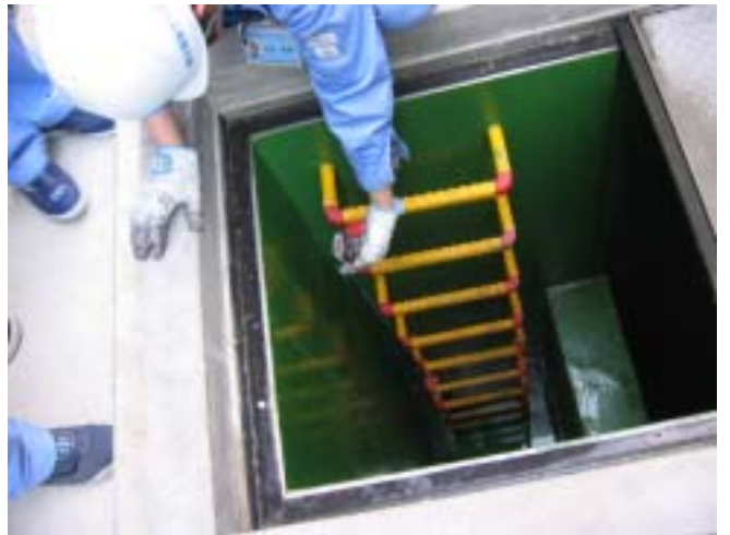
非常用溜枡の点検状況
