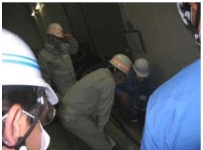
溶接の点検状況の確認
