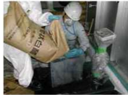
(6) 活性炭充填 (活性炭吸着槽エリア)
