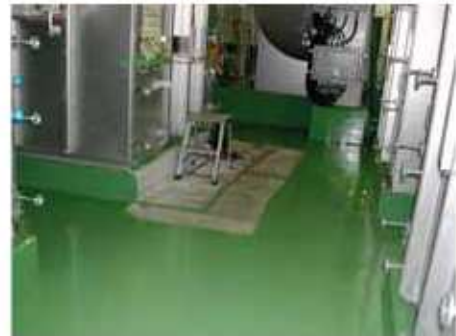
(8) 養生取り外し、清掃
