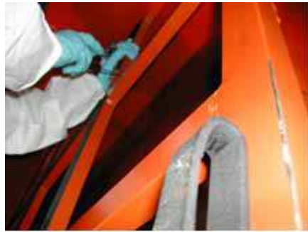
(5) 活性炭吸着槽内ガスケット剥がし
