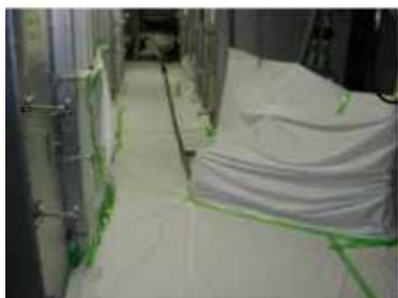
(1) 作業エリア養生 (活性炭吸着槽エリア)
