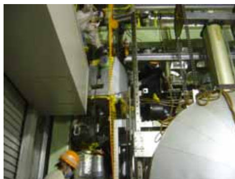
熱交換器取替状況
