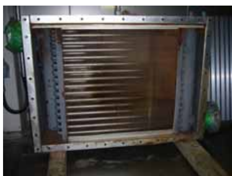
取り外した熱交換器
