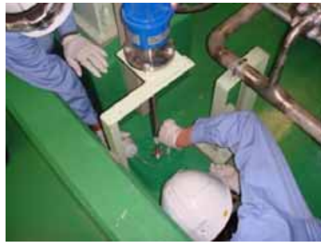
静電容量式漏洩検知器
