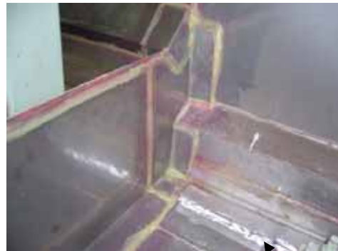
ステンレス板で巻き込みコーキングの上にアルミテープ貼り
