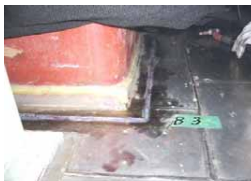
真空加熱エリア （主柱部の溶接完了箇所）
