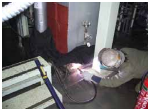
真空加熱エリア溶接作業 （主柱部の溶接）
