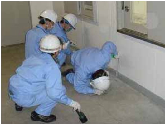
流出防止堤の点検状況
