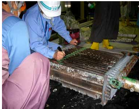
破損していない熱交換器 の解体点検作業 （C号炉（A））
