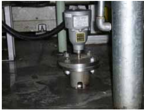
フロート式漏洩検知器
