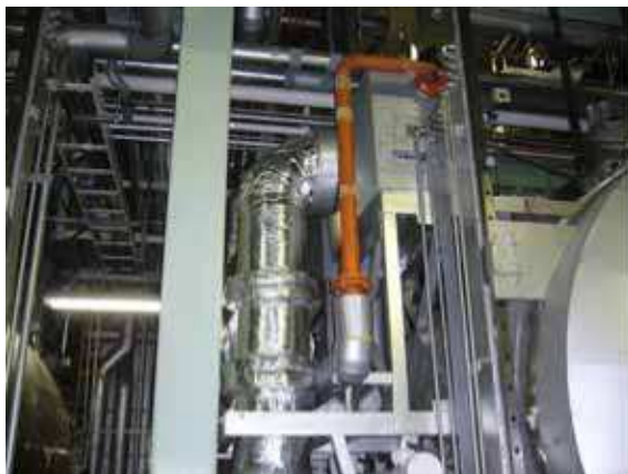
保温材を剥がした熱交換器
