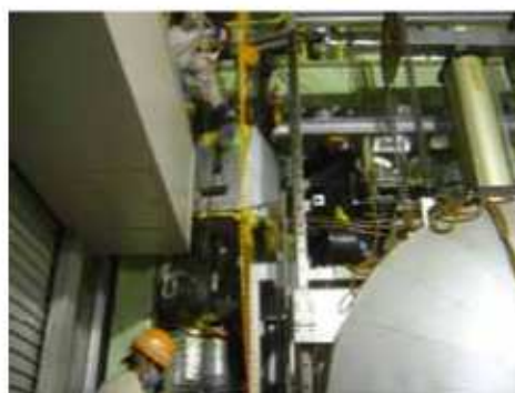
熱交換器取替状況
