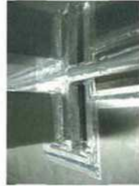
7Mシール貼付施工後
