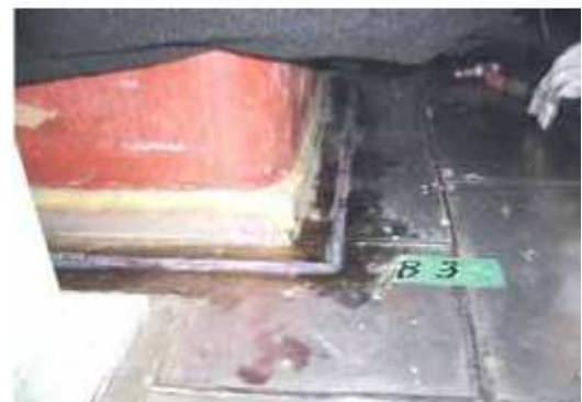
真空加熱エリア (支柱部の溶接完了箇所)
