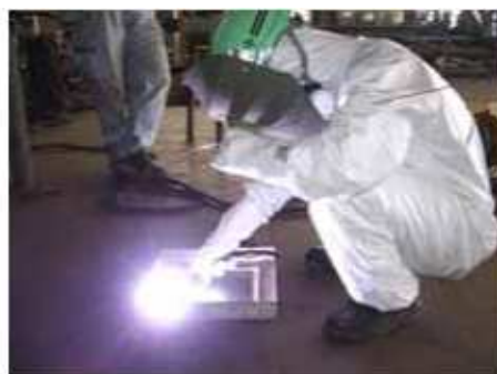
防護服に遮光マスク溶接検証
