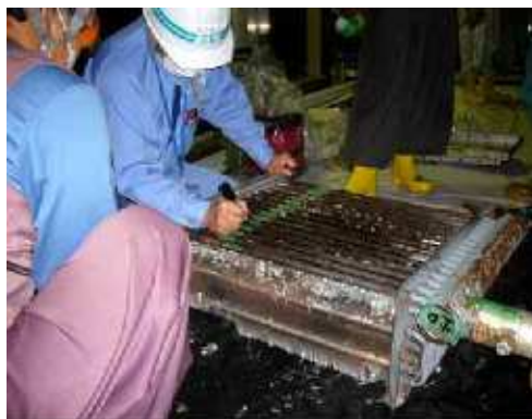
破損していない熱交換器 の解体点検作業
