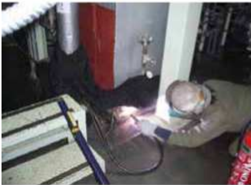
真空加熱エリア溶接作業 (支柱部の溶接)
