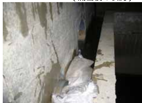
(少量排水側溝部土嚢閉止状況)
