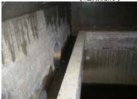
(雨水調整槽内 少量排水側溝)
