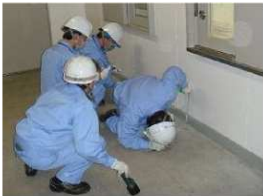
【流出防止堤の点検例】
