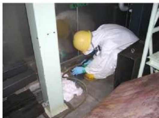
【遮蔽フードの点検例】
