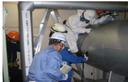
蒸留塔内部のファイバースコープによる点検
