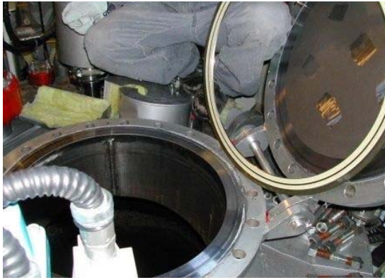
反応槽内部の点検
