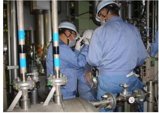
副反応槽内部のファイバー・スコープによる点検
