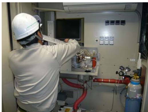
検出部の点検
