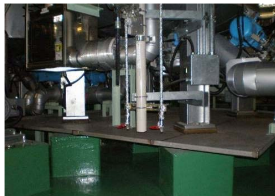
オイルパン(床から離して設置)
