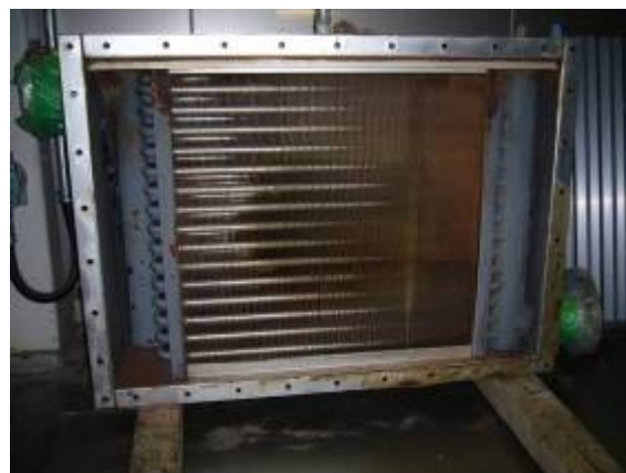
取り外した熱交換器
