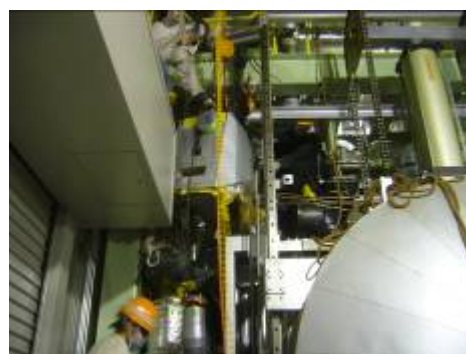
熱交換器取替状況
