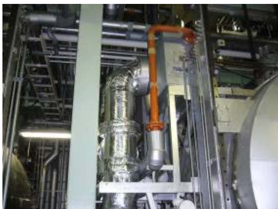
保温材を剥がした熱交換器
