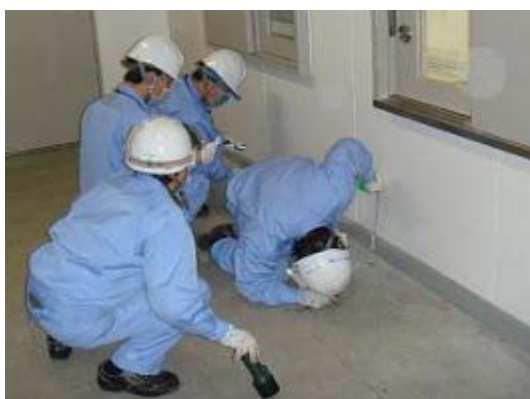
流出防止堤の点検状況
