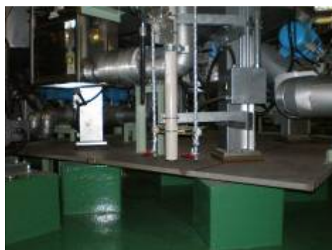
オイルパン（床から離して設置）
