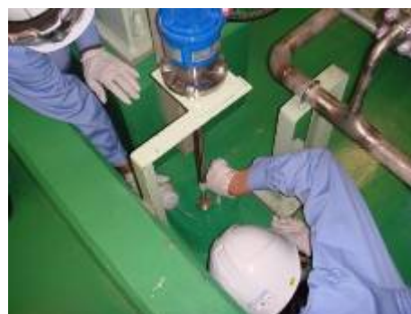
静電容量式漏洩検知器
