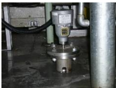
フロート式漏洩検知器
