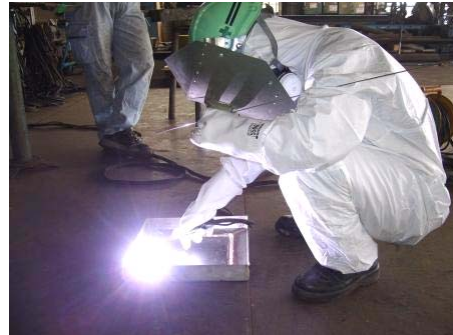
防護服に遮光マスク溶接検証
