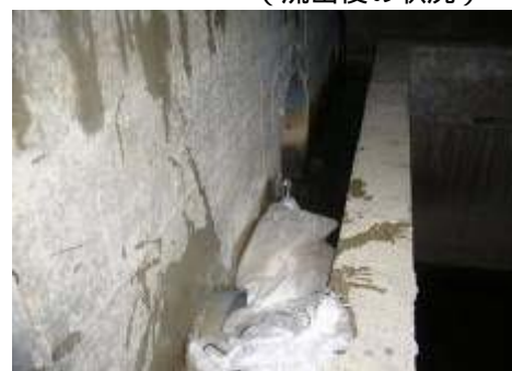
(少量排水側溝部土嚢閉止状況)
