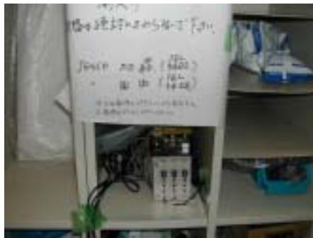
振動測定装置(コンパクトレコーダ、センサアンプ)
