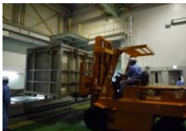
豊田処理施設での積み下ろし作業
