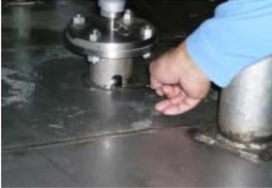
フロート式漏洩検知器
