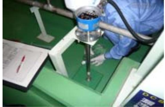
静電容量式漏洩検知器
